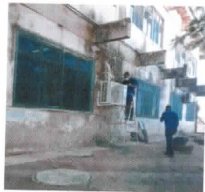
Figura 2. Manutenção corretiva ar condicionado Fracionamento
