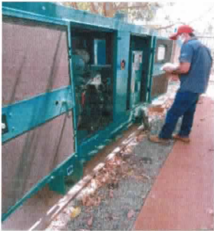
Figura 7. Manutenção gerador
