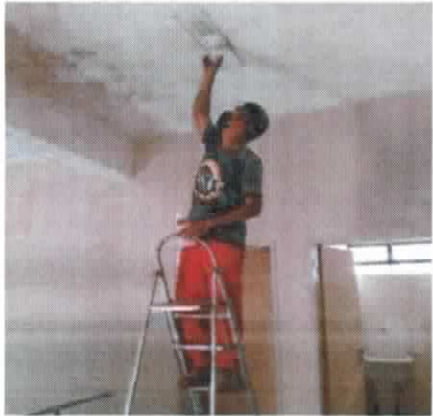
Figura 5. Manutenção preventiva ares condicionados
